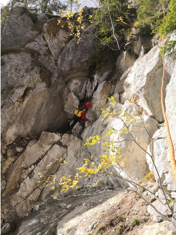
Stefan Wenger, Techn. Leiter Forstbetrieb und Höhenarbeiter Level 2 an der vorgängigen Felsreinigung.
